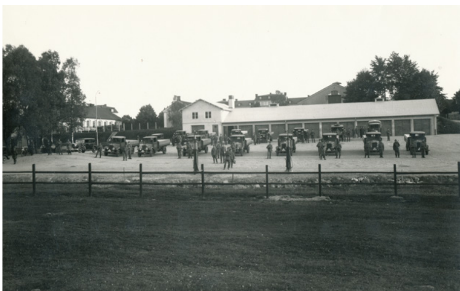
Första bilkompaniet framför varmgaraget, senare utbildningsverkstaden. Byggnaden revs våren 2013.
