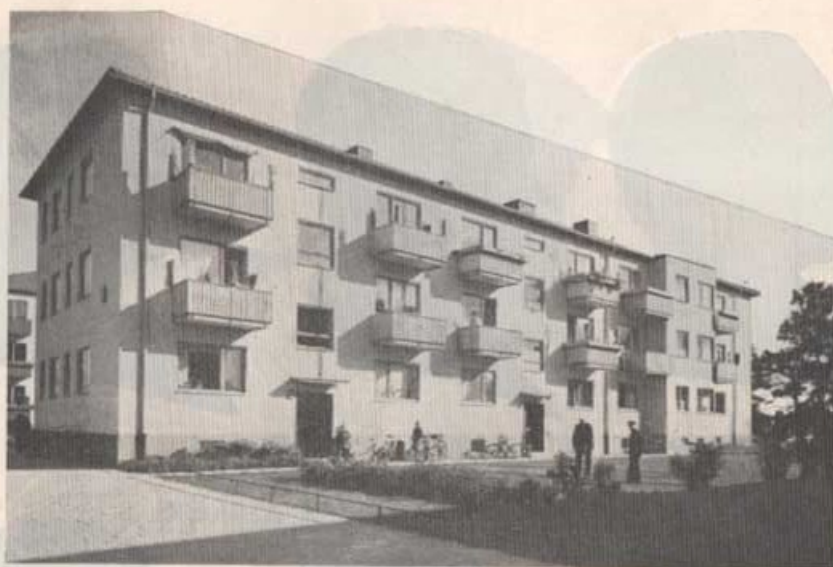
Ett av HSB-husen vid Tredje Avenyen
