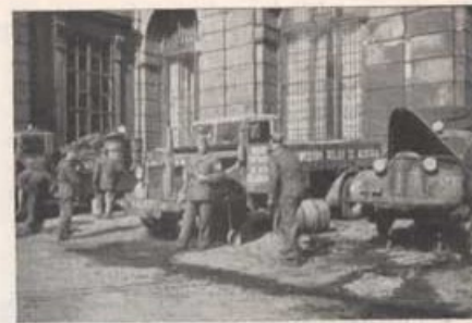
Ing. Erik Westerberg med vår reparationsverkstad vid Lichtensteinalpalas, Wien
