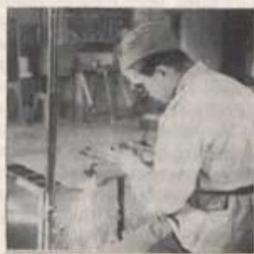
Skärning med svetslåga kräver vaket öga och säker hand. Acetylen- och syrgas i rätt blandning.
