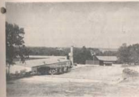
Utsikt från nordvästra hörnet av kaserngården över smörj- och spölsplanen med de nya smörjbryggarna och stora spoisplattan. I fonden det nybyggda övningsmaterieförrådet.
