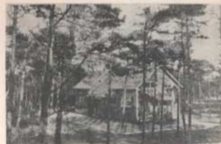
Marketeribygnaden i Tylebäck.
