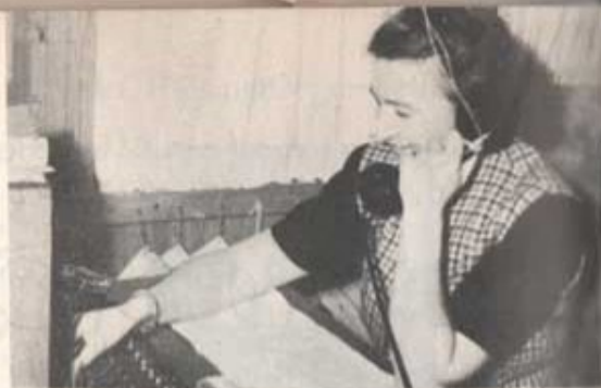
"Tränregementet!" Fröken I. Bladhs glada stämma i telefonväxeln förmedlar våra samtal med yttervärlden.
