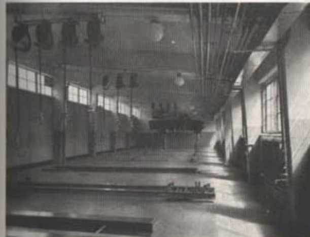
Interiör av den nyinredda smörjhallen. Den är utrustad med lyftanordningar m m av modernaste slag. Lägga märke till olje- och fettsprutornas konstruktion och upphängning.
