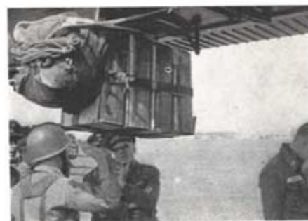
Montering av jeepdunkar för fjällning från flygplan
