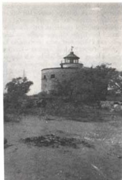
Store Tårn med framförvarande "puggel", Pumpen
