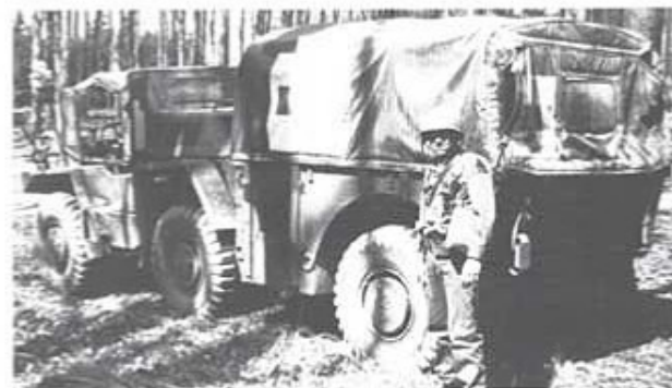
Sjuktransportterrängbil, kallad "Geten", drivning på alla hjul, god terrängframkomlighet (2 liggande + 2 sittande).
