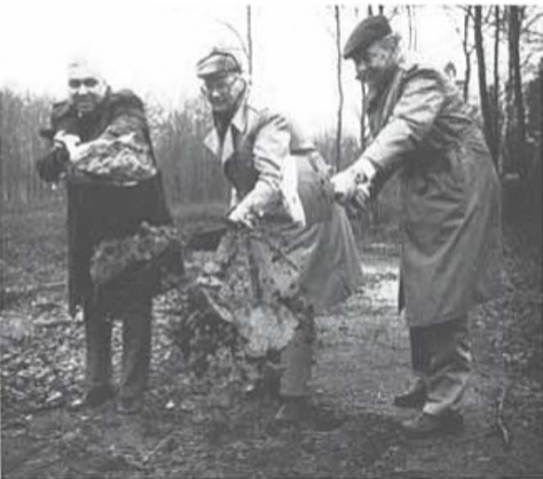
Fortifikationsförvaltningens generaldirektör Erik Petersson flankeras av Lennart Persson och Gustav Nilsson, representanter för entreprenörfirman, då första spadtagen till T 4 nya kaserner vid P 2 togs.
