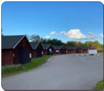
Garagen vid Linberedning/läkemedels-förrådet
