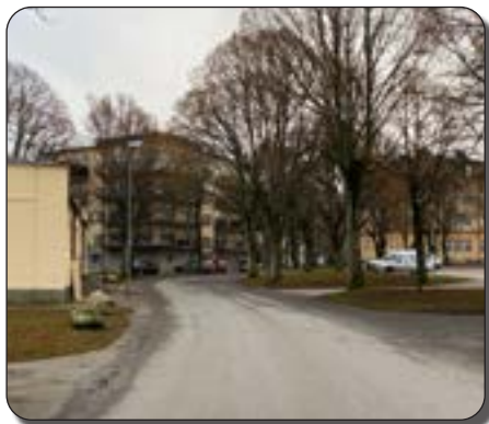
Gymnastiksalen – nybygge – kanslihus
