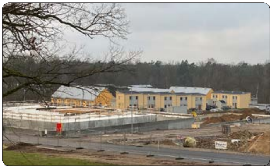
Bostadshus på Wendesplan. Förskola under uppbyggnad mellan motorförrådet och kasern Karlsborg
