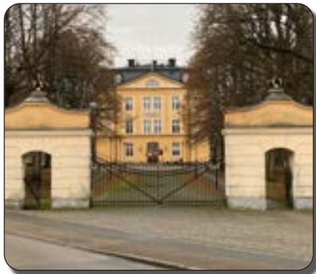
Kanslihuset sett från Vankivavägen
