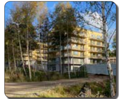
Bostadshus på f.d. drivmedelsplatsen sett från bilbron
